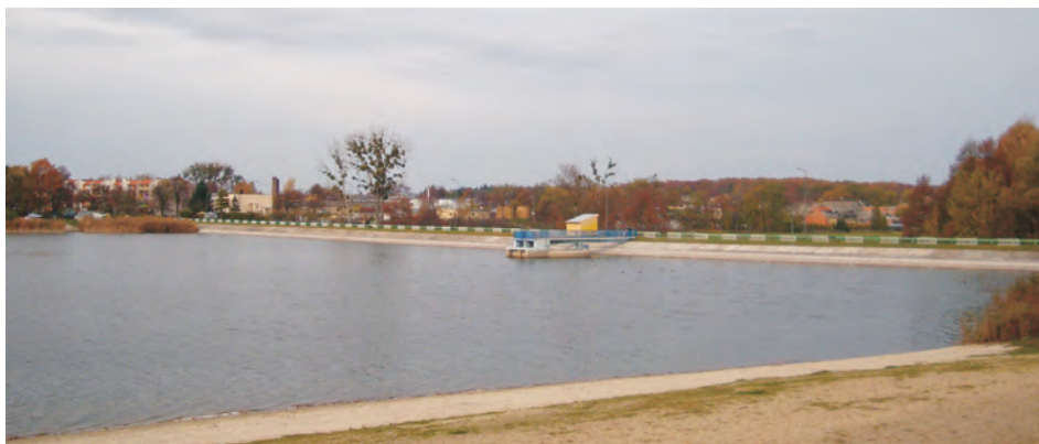
Fot. 1. Zapora ziemna na Ciemnej (lewy dopływ Proсны), zbiornik retencyjny w Gołuchowie Photo 1. The earth dam on the Ciemna river (the left tributary of the Proсны), a reservoir in Gołuchów.
