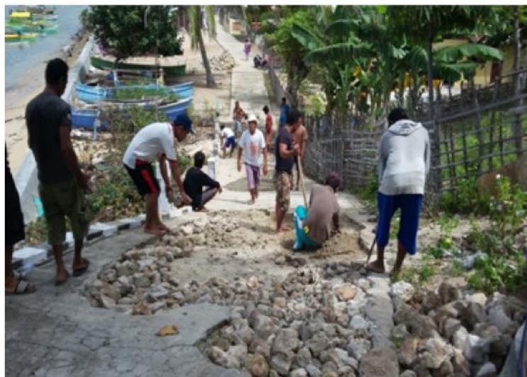
Gambar 7. Kegiatan perbaikan jalan menuju kawasan wisata pantai
