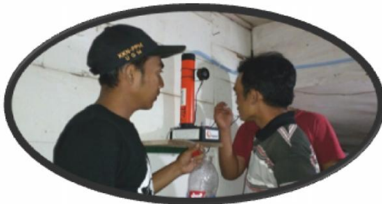
Gambar 6. Pemasangan sipendil (sistem peringatan dini longsor) bersama warga
