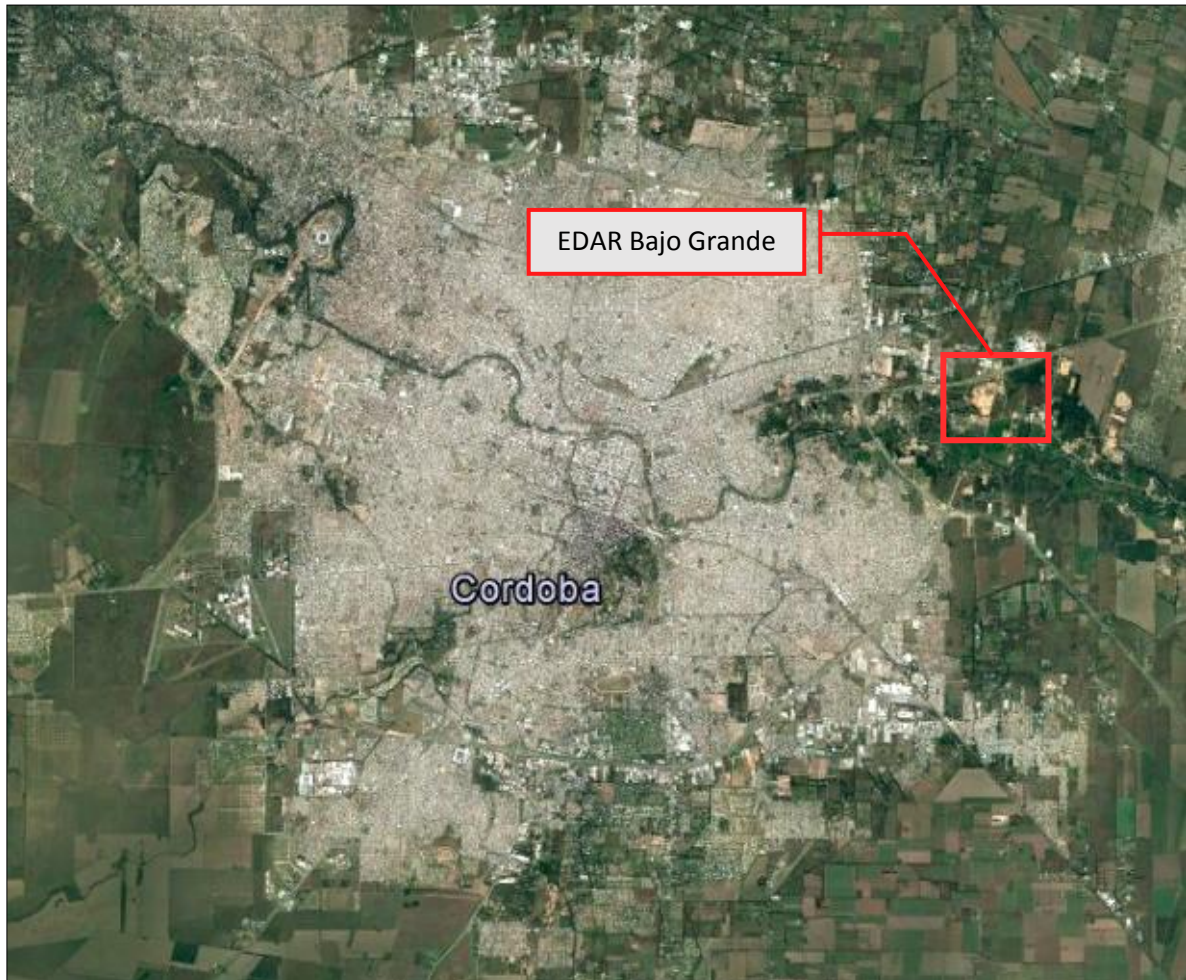
Figura 2.1-Localizacion EDAR Bajo Grande
