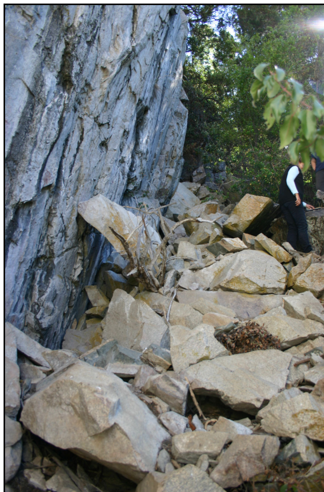
Figura 5: Vista del derrumbe.
