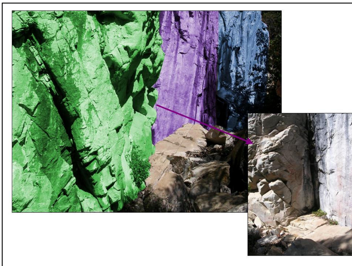
Figura 6: Sectorización de P2. Sector 1 (verde), Sector 2 (violeta) y Sector 3 (azul). En el detalle se muestra el sector de inflexión de la pared.
