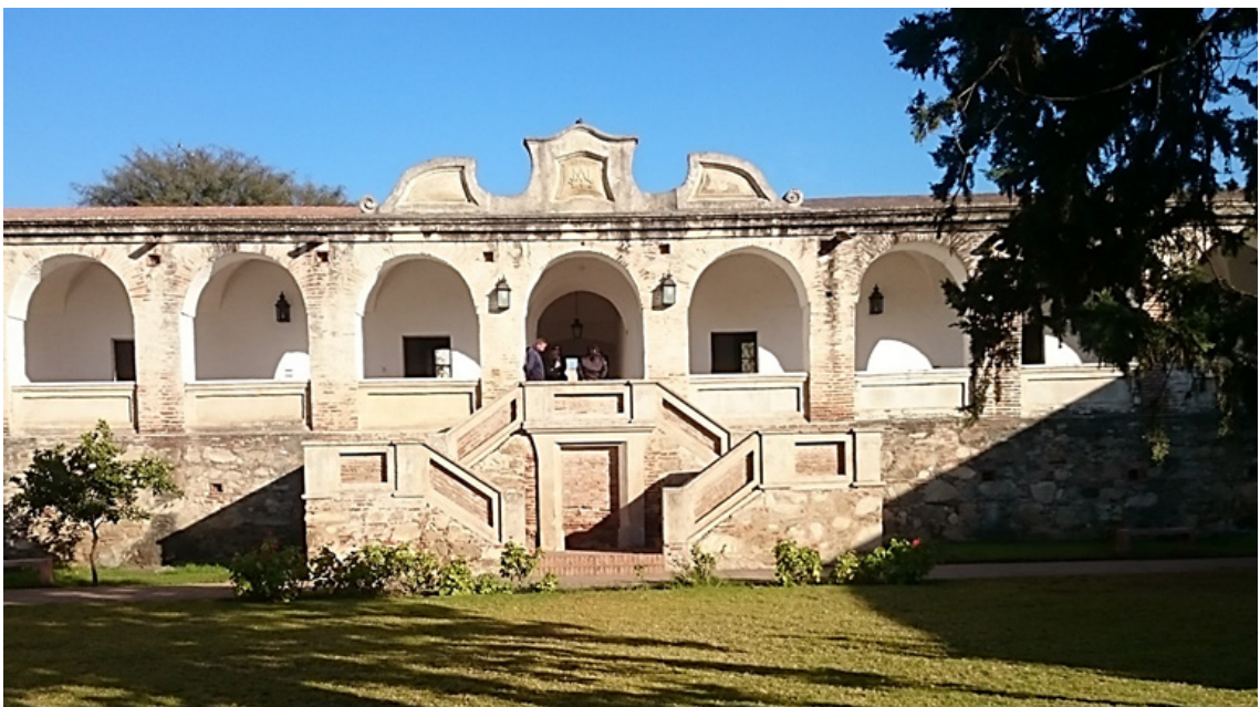
Ilustración 25: Escalera doble y frontón sobre el primer patio.
