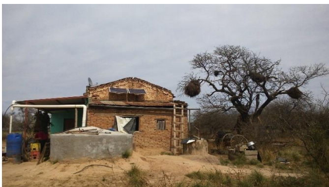
Figura N° 21: Cisterna y paneles solares.
