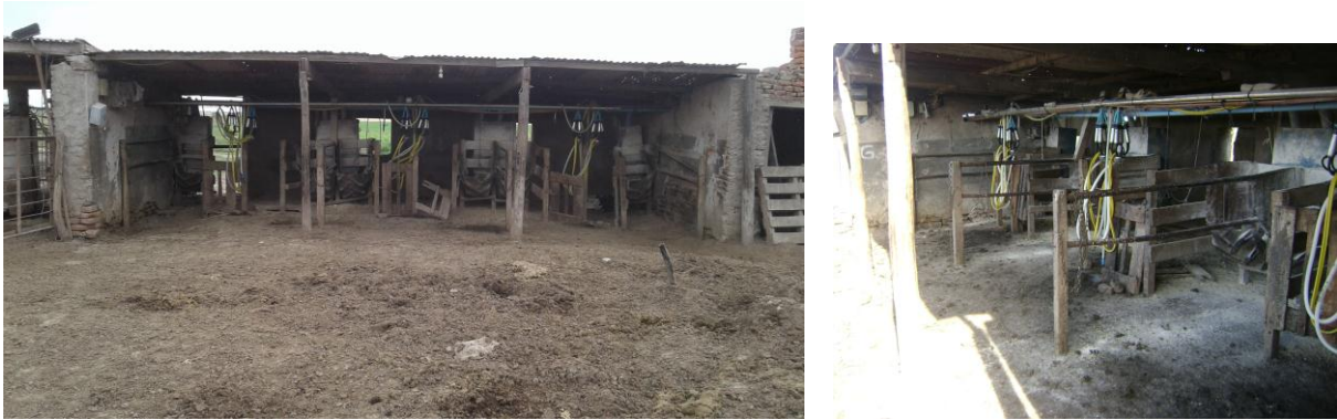
Figura 10: Sistema de sujeción tipo brete a la par
