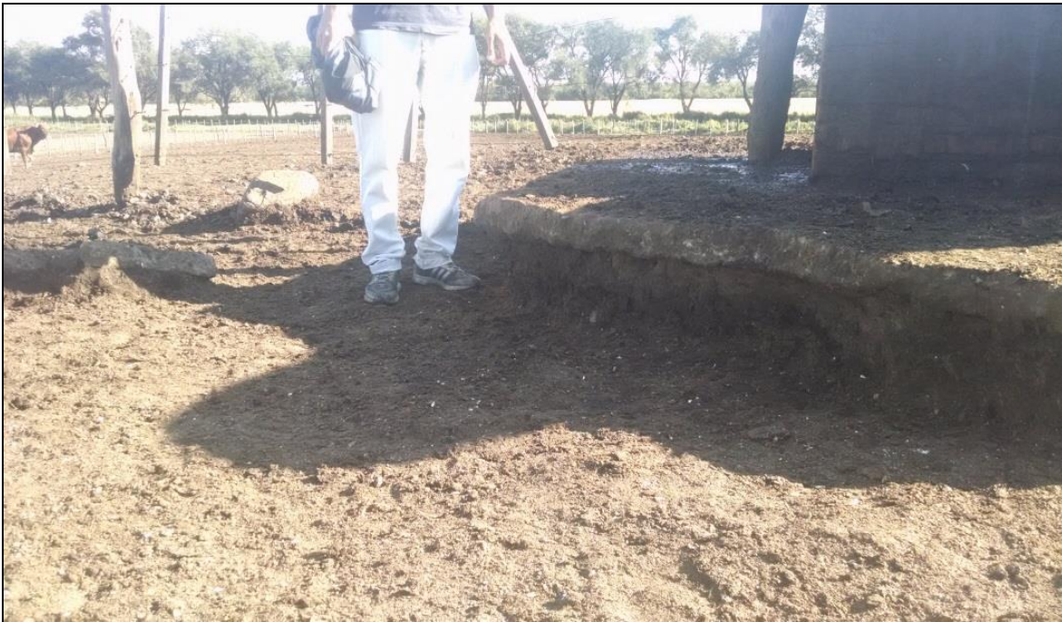
Ilustración 59: Vereda de cemento de escasas dimensiones provoca la formación de desniveles dificultando abrevar al ganado.
