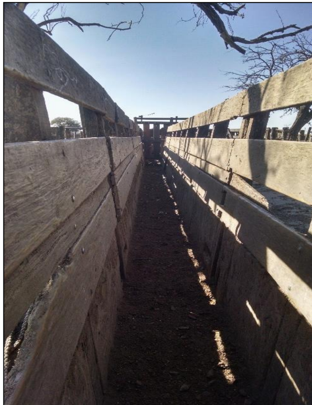
Ilustración 45: Manga de trabajo con paredes rebatibles pero sin piso de cemento.
