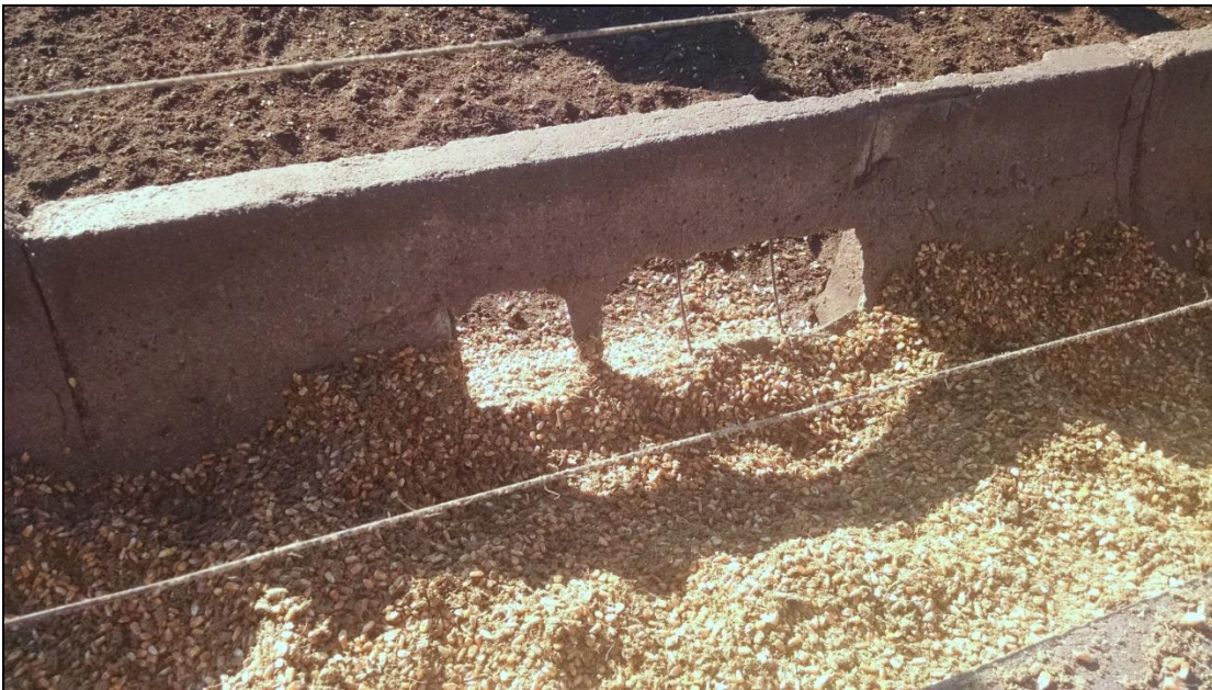
Ilustración 53: Rotura en las paredes del comedero que ocasiona pérdidas en la ración suministrada.
