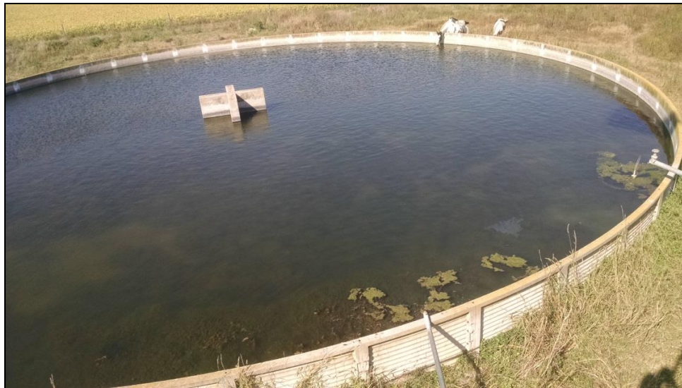
Ilustración 56: Tanque australiano que almacena el agua destinada al engorde a corral.
