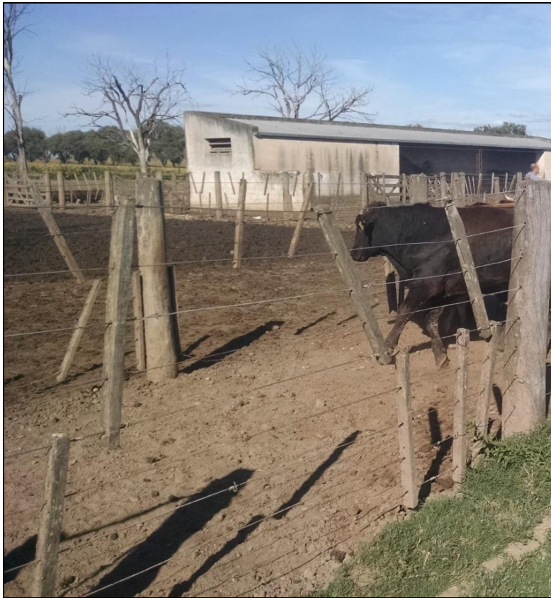
Ilustración 42: Alambrados con mal estado de mantenimiento de sus varillas.
