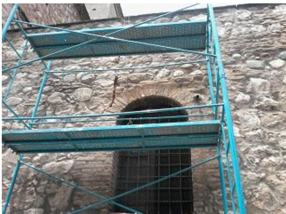
Foto 20: detalle de los andamios montados y parte de la perforación antes de detenerse los trabajos.
