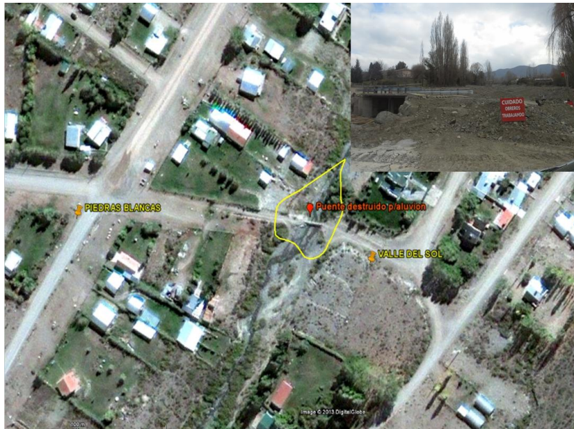
Figura 8. Vista en planta del puente destruido por el proceso aluvional de febrero de 2013, y su reconstrucción en marzo del mismo año
