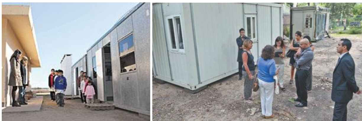
Figura 7. Aulas containers utilizada en la Provincia de Córdoba - Argentina Fuente: (Elbarriopueyrredon, 2011)
