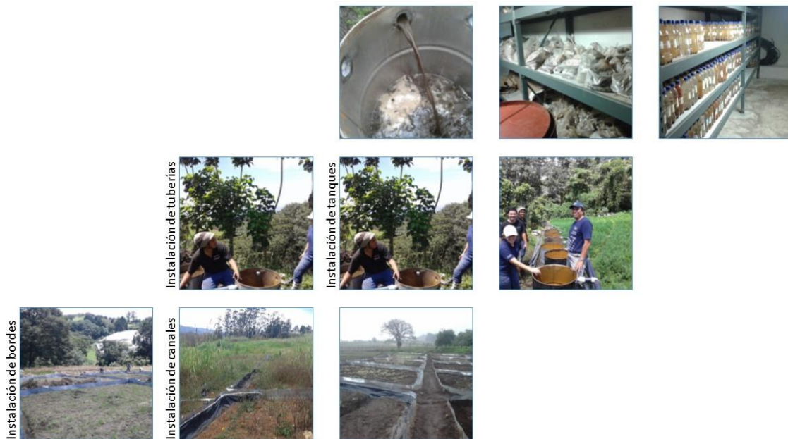
Figura 4. Proceso de instalación de las parcelas de escorrentía
