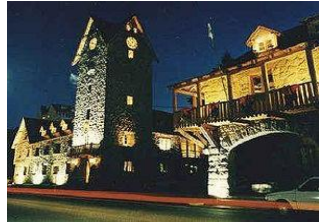
Imagen 8: Centro Cívico Bariloche. Fuente: www.plataformaurbana.com
