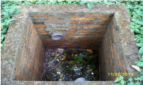
Foto 4. Pilas de Retención
