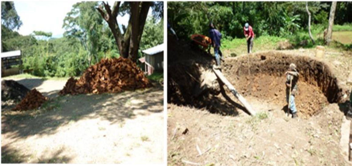
Foto 21 y 22: Construcción de un biodigestor
