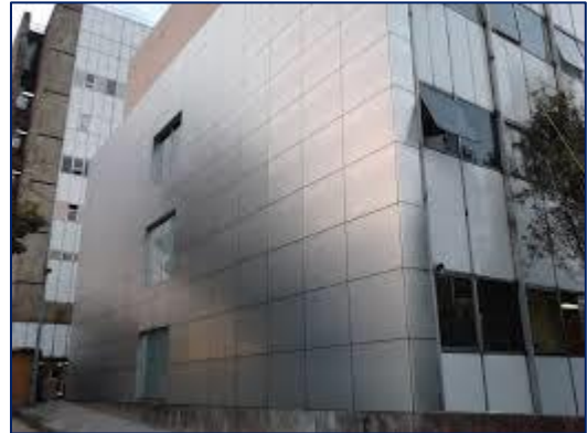
Ilustración 69; Paneles instalados en fachadas
