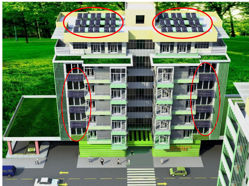
Ilustración 60; Localización de los paneles solares
