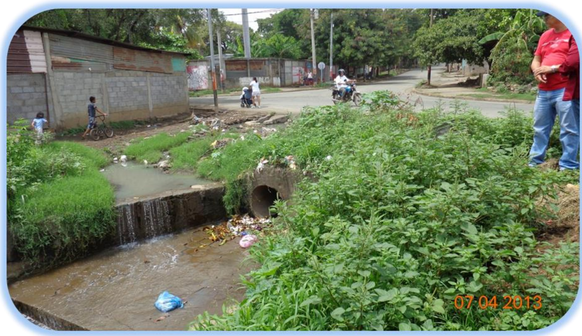
Salida de Tubería de las aguas pluviales del cauce del Barrio Francisco Salazar y donde inicia el cauce.
