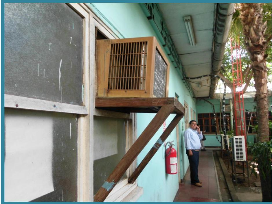
Fotografía N° 23 Mal estado de los equipos de aire acondicionado.
