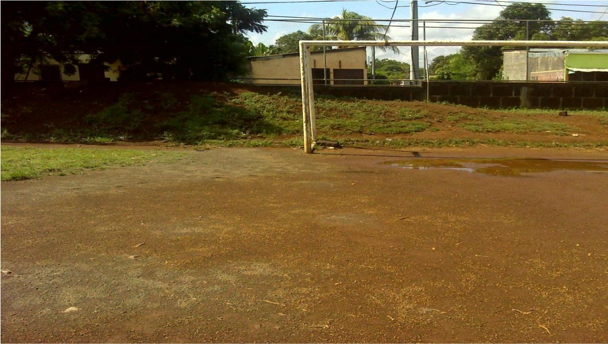
Debido al desnivel del terreno se acumula agua pluvial, se necesita hacer el respectivo corte y relleno.
