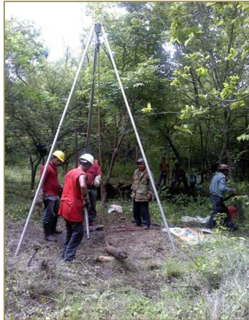
Figura 5.1. Perforación de SPT realizada en FAREM-Chontales (CIGEO, 2012).
