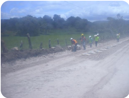
Carretera en construcción
