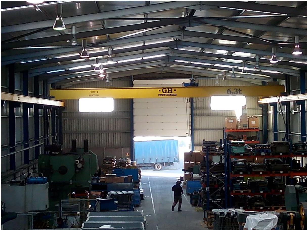
Figura 38 Ponte grua rolante sobre a fábrica
