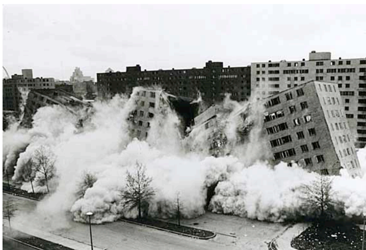
Ilustración 23. Demolición de los edificios Pruitt Igoe 68
