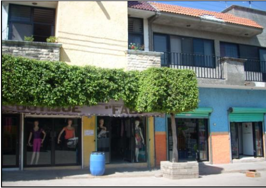
Las calles con mayor comercio han destinado la planta baja para locales comerciales y la planta alta para vivienda.
