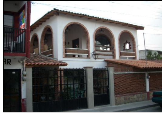
Este tipo de vivienda intenta integrarse al estilo tradicional pero sobre pasa las características de las casa de adobe.
