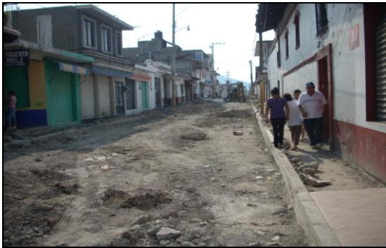
Pavimentación o empedrado de las principales calles de la cabecera municipal.
