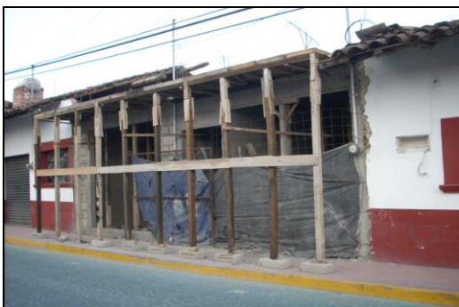
Las remodelaciones a las viviendas que se encuentran en el centro tienen que apegarse al Reglamento de Imagen Urbana del municipio, aunque integren nuevos materiales de construcción.
