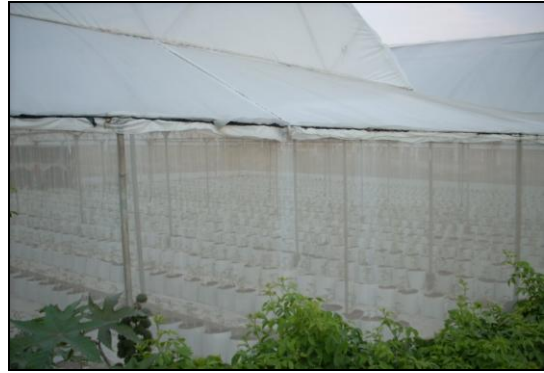
Vista exterior del invernadero.
