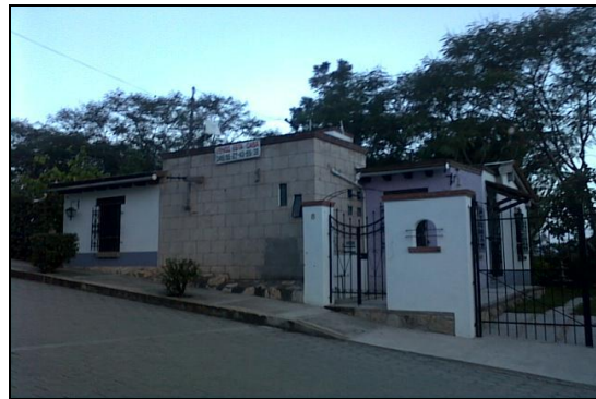
Se insertan nuevos elementos que logran una arquitectura pueblerina.
