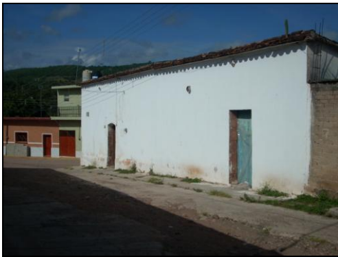
Vivienda tradicional hecha de adobe y teja; hoy día es poca la vivienda de este tipo que se encuentra en buenas condiciones.
