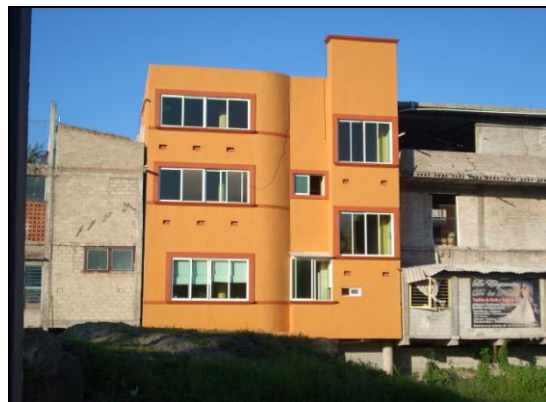
Otro tipo de vivienda son los departamentos en edificio.
