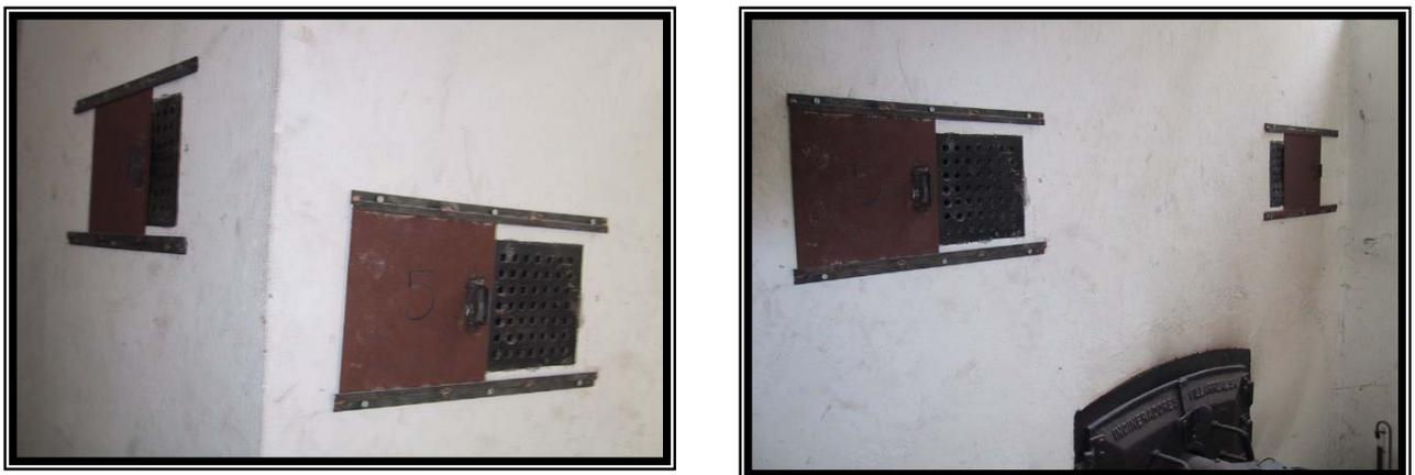
Figura IV.7. Placas de control de ingreso de aire a las cámaras primaria y secundaria
