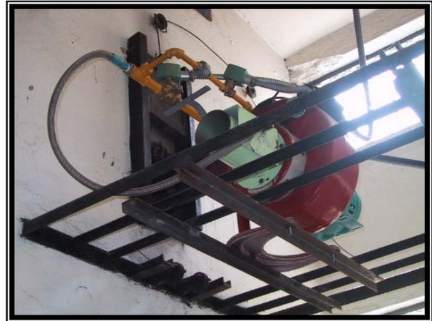
Figura IV.8. Dispositivo de control de ingreso de aire los quemadores
