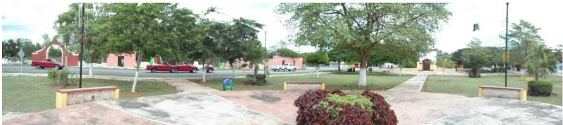
Figura 35. Estado actual de la plaza administrativa de la Hacienda de Dzibilchaltún, se observa el remate visual hacia el templo porfiriano. Fuente: Reyes, 2011.
