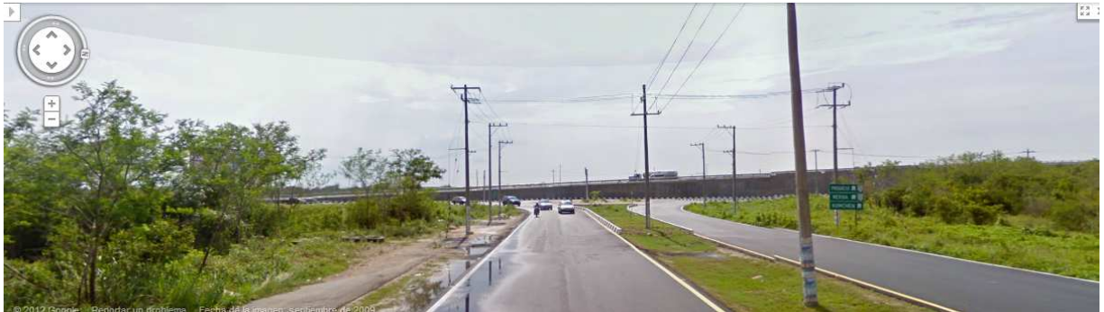
Figura 4. Acceso poniente de Dzibilchaltún. Fuente: [Internet] Google Street View, 2012.
