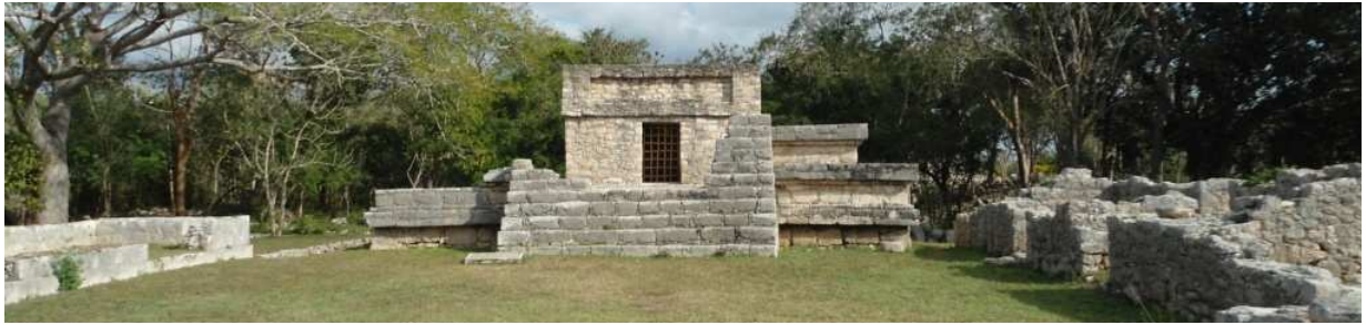
Figura 19. Estructura 38-sub. Estilo arquitectónico del Periodo Temprano II. Fuente: Reyes, 2012.
