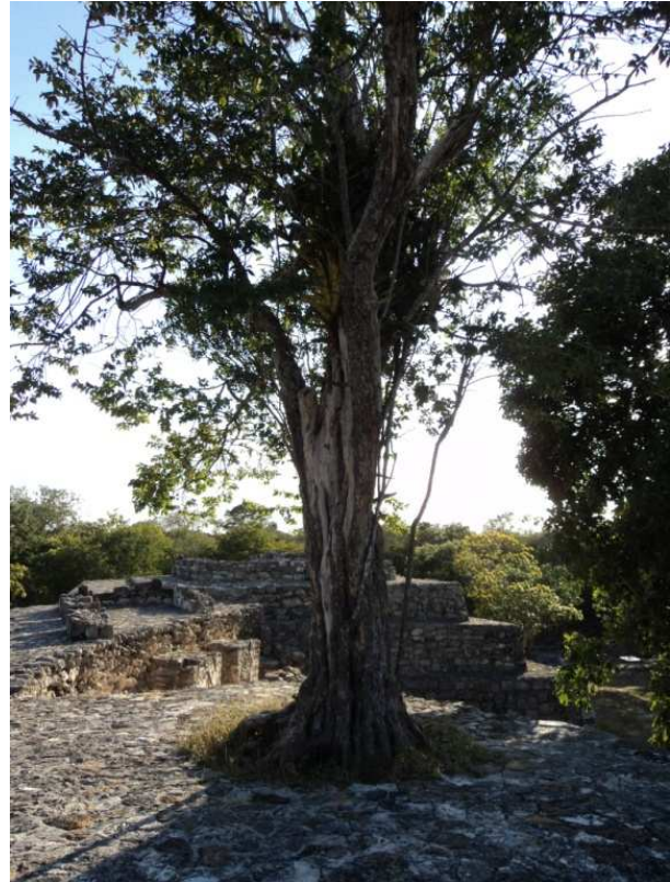
Figura 54. Árbol de 6-7 m de alto sobre la estructura 45. Fuente: Reyes, 2012.
