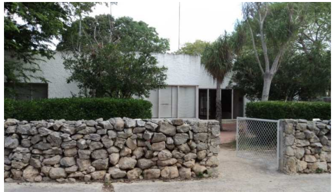
Figura 81. Oficinas INAH Dzibilchaltún. Fuente: Reyes, 2011.
