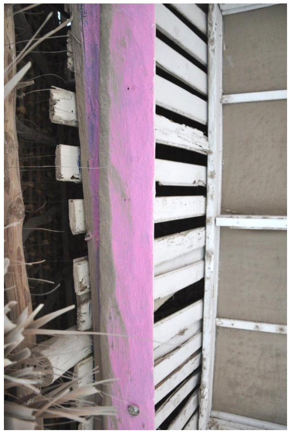
Vista del entarimado de la cubierta.
