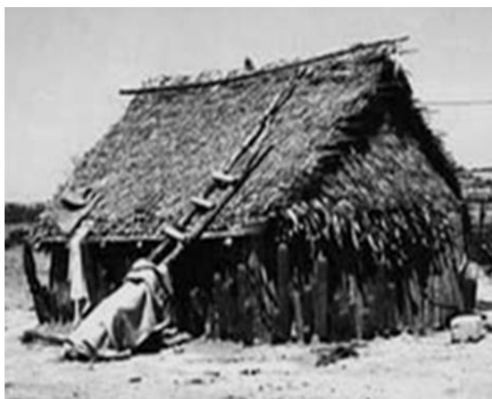
Ilustración 6 Foto. Vivienda Huasteca en Santa Catarina Hidalgo. Autora: Mariana Yampolsky. Fuente: La casa que canta. Arquitectura Popular mexicana. SEP, 1982
