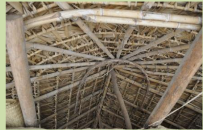
Cubierta de zacate colorado en manojos encimado. Ciudad Valles, S.L.P.
