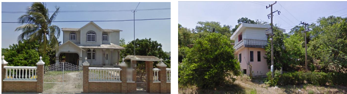
Ilustración 13 Foto. Viviendas de migrantes en la Huasteca Potosina, se observan patrones de vivienda que no tienen relación con la arquitectura Huasteca. Autora: S.L.G. diciembre 2009
