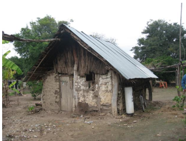
Ilustración 47 Foto. Vivienda que utiliza lámina galvanizada sobre el sistema constructivo tradicional. Ocampo, Tamps. Autora: S.L.G. 2009.
