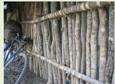
Muro en vivienda de Nicolás Bravo, Tamaulipas
