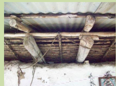
Cubierta de metálica con entarimado en Huejutla, Hgo.
