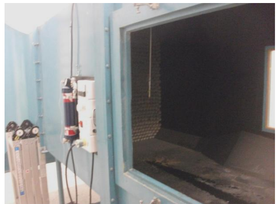
Figura 115. Colocación de chaflanes en interior de Túnel de Viento
