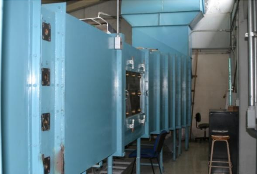
Figura 111. Túnel de Viento en ubicación anterior
