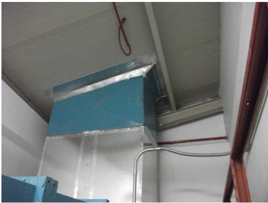
Figura 114. Adecuación en salida de Túnel de Viento
