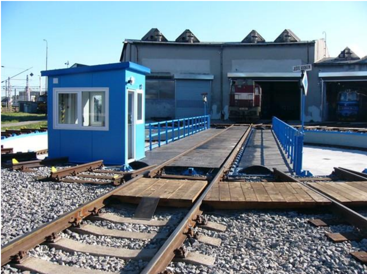
Obr. 13.: Celkový pohled na točnu po rekonstrukci
