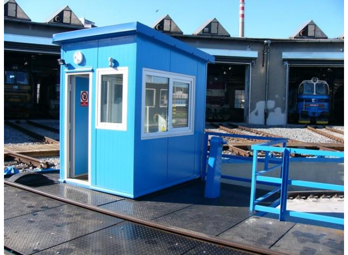
Obr. 15.: Kabina po rekonstrukci
