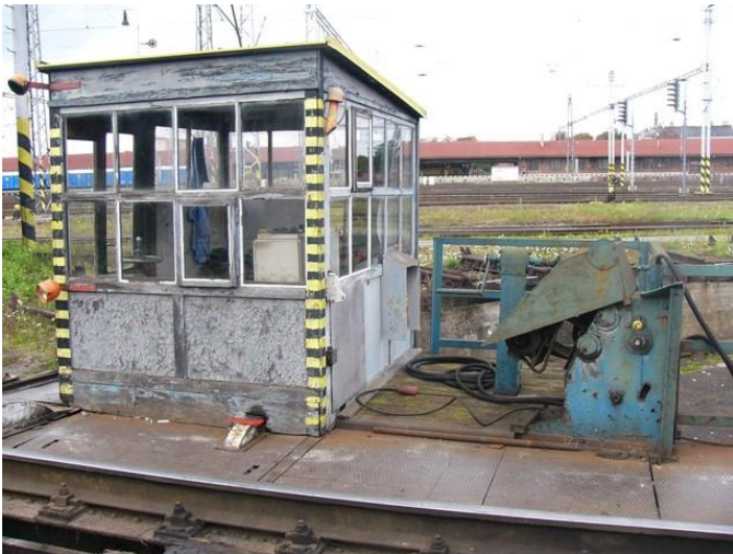
Obr. 14.: Kabina před rekonstrukcí
