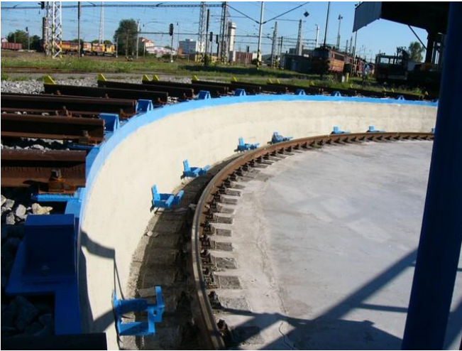
Obr. 22.: Járna po rekonstrukci se snímači
