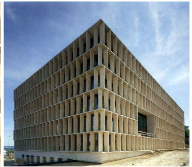
1000-bed hospital, kortijk: baumschlager + eberle
