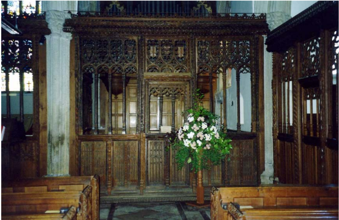
Fig. 39. Type 10 (parclose) screen. Holbeton.
