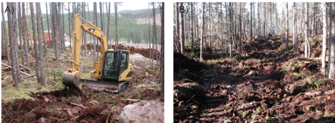
Figure 1.17. Traitement de scarifiage. A) Pelle rétrocaveuse dans un sentier de débardage. B) Placeaux de scarifiage. Roger Gagnon, 2003.
