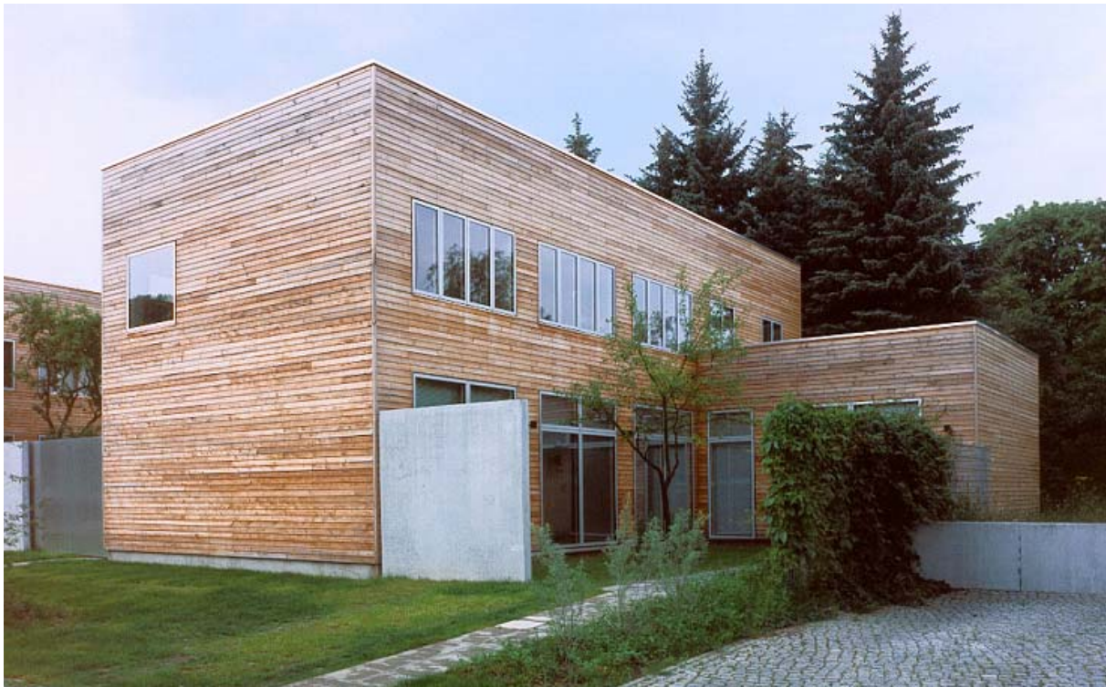
Gartenhofhaus Berlin Zehlendorf gereiht (Architekten Becher+Rottkamp)
