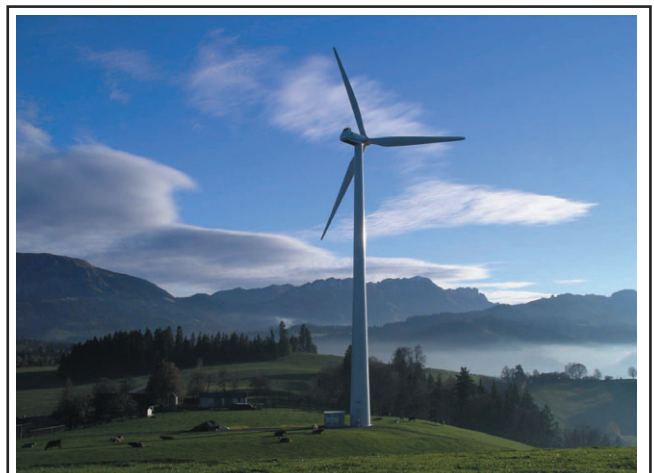
Abb. 11: Windkraft: Die Leistung einer modernen Anlage beträgt etwa 2 Megawatt (= Versorgung von bis zu 2.000 Haushalten im Jahr mit Energie). An günstigen Standorten (bei ca. 1,5 MW) können in 20 Betriebsjahren rund 76 Mio. kWh Strom erzeugt werden (= Verbrennung von ca. 84.000 t Braunkohle), Quelle: http://www.tourismus-entlebuch.ch/Bilder/Windkraftanlage.jpg .
