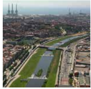
▲ Riqualificazione del Besòs, Barcellona, 2004 (foto di Consorci del Besòs)
