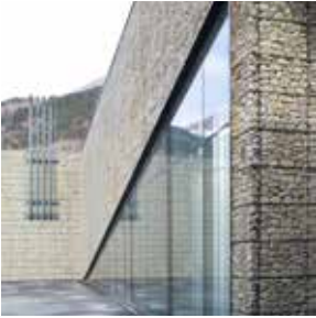
▲ Markus Tauber Architectura, centrale di teleriscaldamento, Silandro, 2009 (foto di René Riller)
