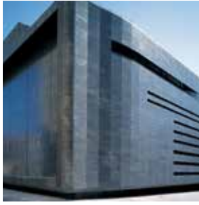
▲ UNStudio, centrale elettrica, Innsbruck, 2002 (foto di Christian Richters)
