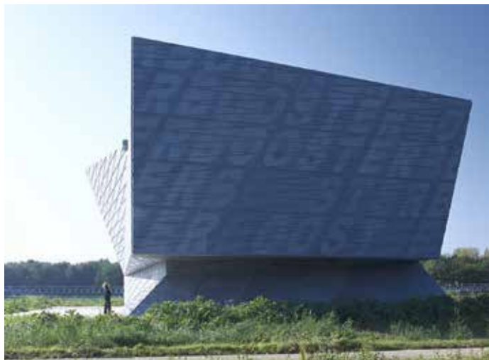
▼ Arhitektura Krušec, generatore per le pompe anti-allagamento, Celje, Slovenia, 2005 (foto di Miran Kambič)
