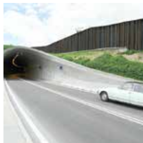
▲ Modus Architects, barriere acustiche, circonvallazione Bressanone-Varna, 2011 (foto di Leonhard Angerer)
