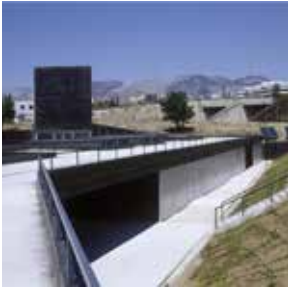
▲ Gonzalo Arias Recalde, Ecoparque Norte Granada, 2002 (foto di ?)
