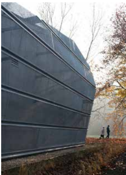
◀ Arhitektura Krušec, generatore per le pompe anti-allagamento, Celje, Slovenia, 2005 (foto di Miran Kambič)
