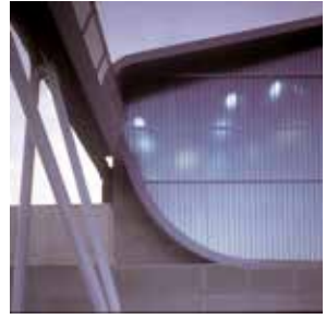
▲ UNStudio, impianto di trattamento dei rifiuti, Delft, 2000 (foto di Ábalos Herreros)
