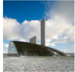
▲ Gottlieb Paludan Architects, generatore di emergenza nell'aeroporto Kastrup di Copenaghen, 2011 (foto di Gottlieb Paludan Architects)
