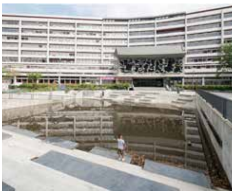
▲ De Urbanisten, Water plaza, Benthemplein, Rotterdam, 2013 (foto di Ossip van Duivenbode, Frank Kaltenbach, Palesh + Azarfane, De Urbanisten)
