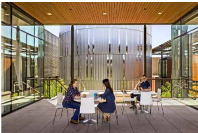
▲ ZFG Architects, centrale elettrica campus Stanford University, Palo Alto, 2006-2007 (foto di ◀ Robert Canfield e Tim Griffith)
