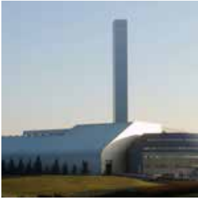
▲ A2A, termoutilizzatore, Brescia, 1998 (foto di Andrea Campanelli)
