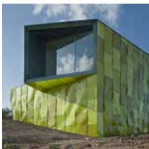
▲ Vaillo + Irigaray, impianto di trattamento dei rifiuti di Huarte, 2015 (foto di Vaillo + Irigaray)
