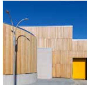
▲ C. F. Møller, inceneritore di Gästad a Linköping, in Svezia, 2004 (foto di Peter Cook)
