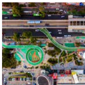
▲ Dissing + Weitling, pista ciclo-pedonale sopraelevata, Xiamen, 2016-2017 (foto di Dissing + Weitling)
