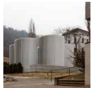
▲ Modus Architects, centrale di riscaldamento di Milland, 2014 (foto di Ganther Wett)
