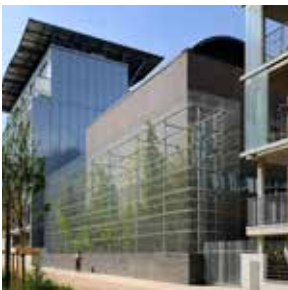
▲ Rue Royale Architectes, estensione della stazione elettrica Perrache, Lyon, 2014 (foto di Studio Erick Sallet)
