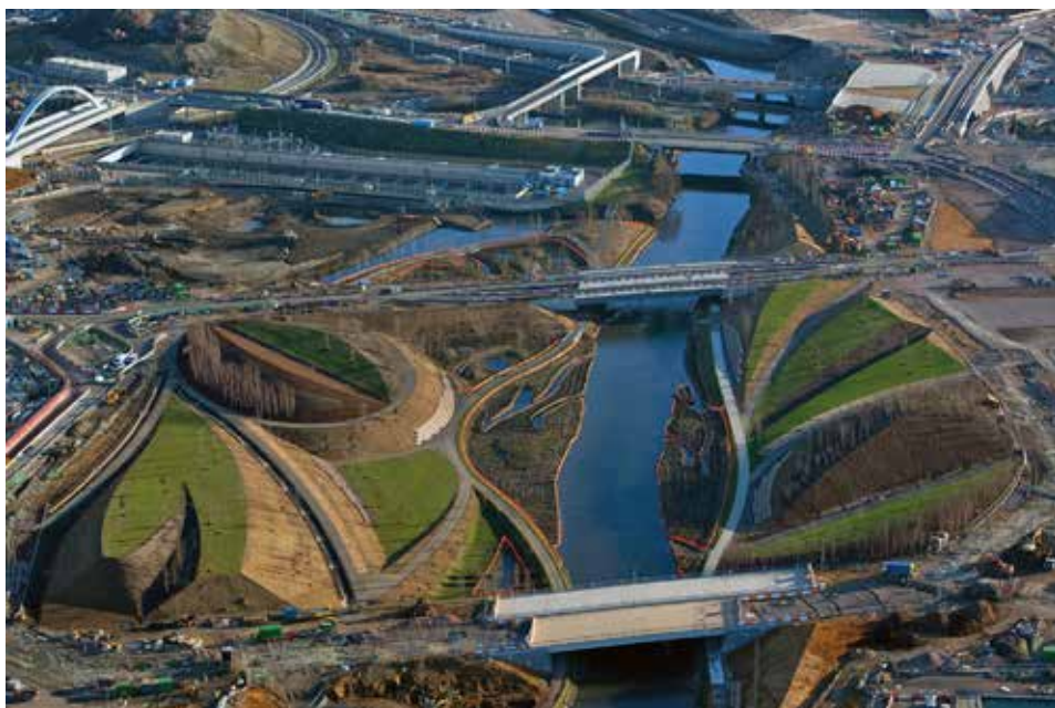
▲ Buro Appold Engineering, Queen Elizabeth Olympic Park, Londra, Sistema di gestione dei flussi idrici e del rischio inondazione, 2012 (foto di Buro Appold Engineering)
