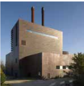
▲ Gottlieb Paludan Architects, generatore di emergenza nell'aeroporto Kastrup di Copenaghen, 2011 (foto di Gottlieb Paludan Architects)
