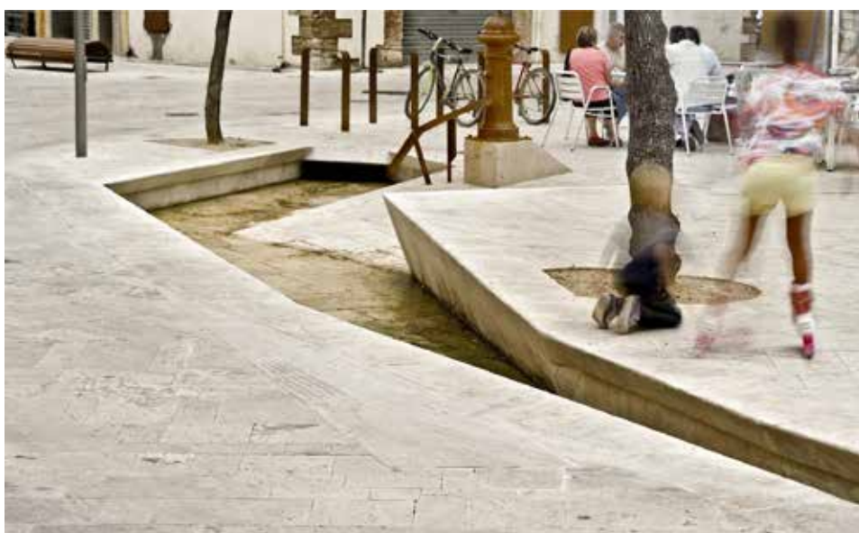
▲ Miàs Architectes, ◀ pedonalizzazione centro medievale di Banyoles, Girona, 1998-2008 (foto di Josep Miàs Architectes e Adrià Goula)
