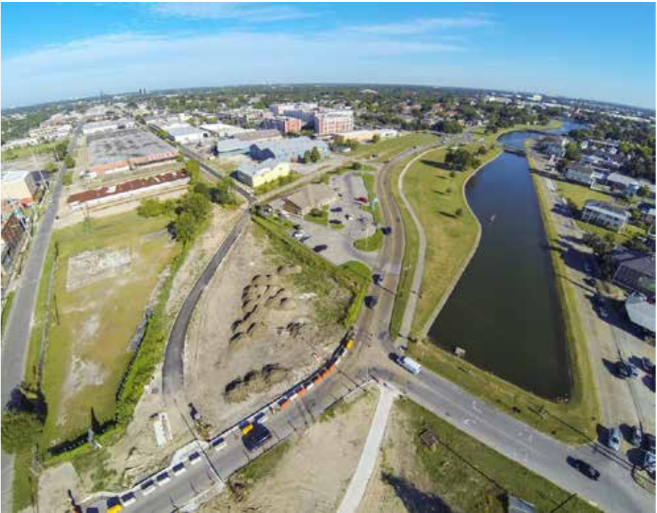
▼ Waggoner & Ball Architects, Lafitte Greenway in fase di realizzazione nel 2016, New Orleans, 2013-2017 (foto di Nola Aerials)
