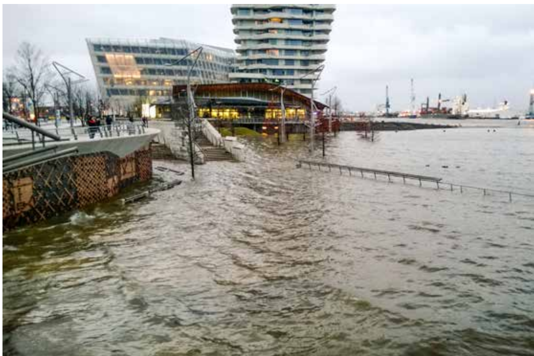
▲ HafenCity, pareti a tenuta stagna di un edificio contemporaneo e di una vecchia costruzione, Amburgo (foto di Florlan, www.commonswiki.org )
