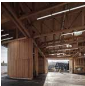
▲ Marte.Marte, waste disposal center, Feldkirch, 2015 (foto di Marc Lins)
