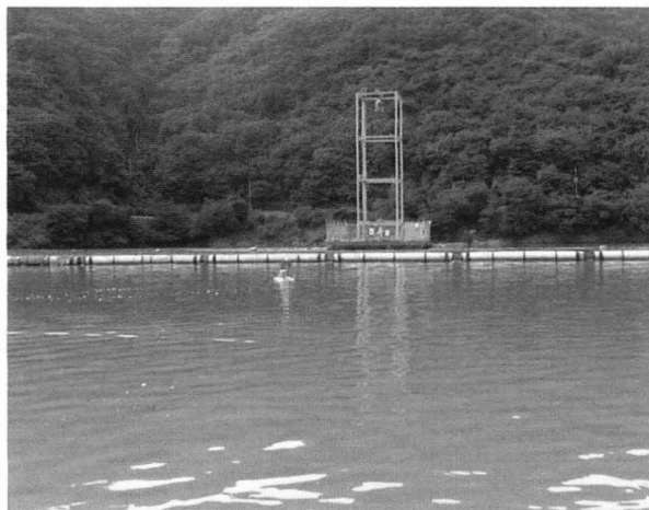
図 2: S 貯水池の密度流拡散装置と実験中の GPS-float (2003 年 9 月 5 日).
