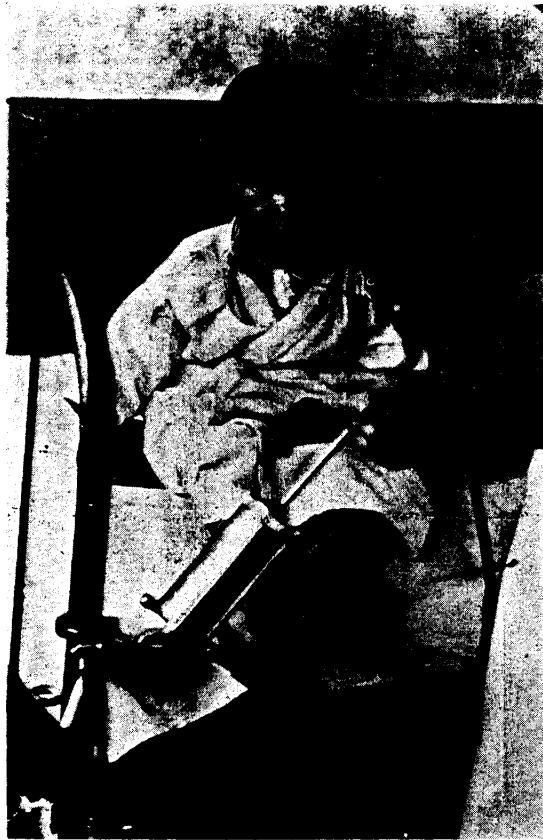
Abb. 1. Obiges Photo zeigt den kleinen Handsaugapparat, an dem wir bezüglich der Saugfähigkeit einige Verbesserungen angebracht haben. Gleichzeitig kann man daraus ersehen, daß man ihn entsprechend den verschiedensten Bedürfnissen leicht von einem Bett zum anderen umbauen kann.
