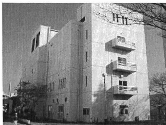
図5 実験動物研究棟の外観 放医研で最も利用者の多い実験動物施設である。 延べ面積 3259.04m 2 昭和53年竣工、平成15年改修
