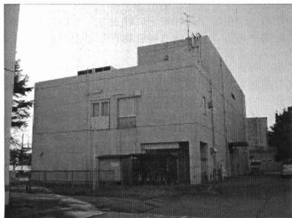
図3 SPF生産・実験棟の外観 延べ面積 1222.90m 2 平成5年竣工
