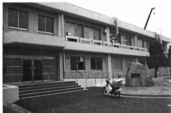
写真1 動物資源部門津島北施設(旧工学部21号館1階)
