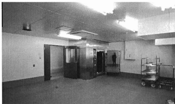
写真2 洗浄機設置前の洗浄室と両扉式高圧蒸気滅菌機
