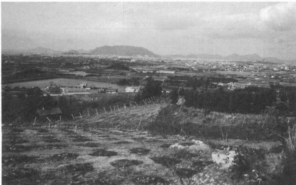
高尾山より撮影・写真中央の建物群
