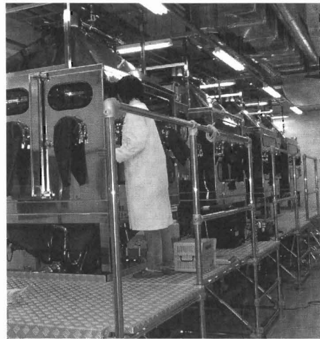
写真-1 3階曝露チャンパー室
