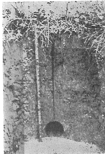
写真—3 モグラ暗渠を施工した直後のセン孔断面
