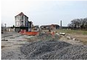
Illustration 3: Le café "Chez Salah" au milieu des travaux
