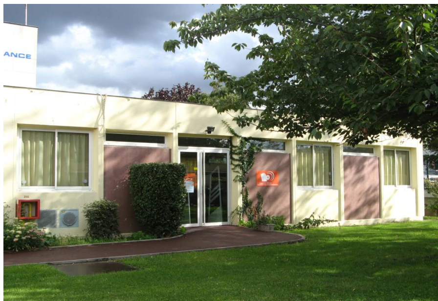
La médiathèque de la Maison de l'Enfance fut incendiée pendant les émeutes de l'automne 2005. Ici, après rénovation, La Courneuve, août 2010
