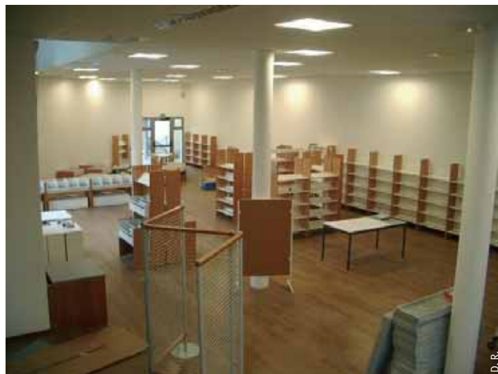
Rosny-sur-Seine. L'installation du mobilier (février 2006).
