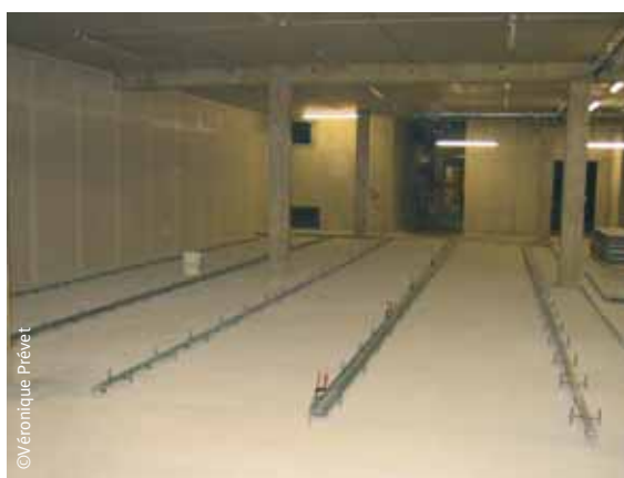
Pose des rails du magasin (BU Rennes 1).
