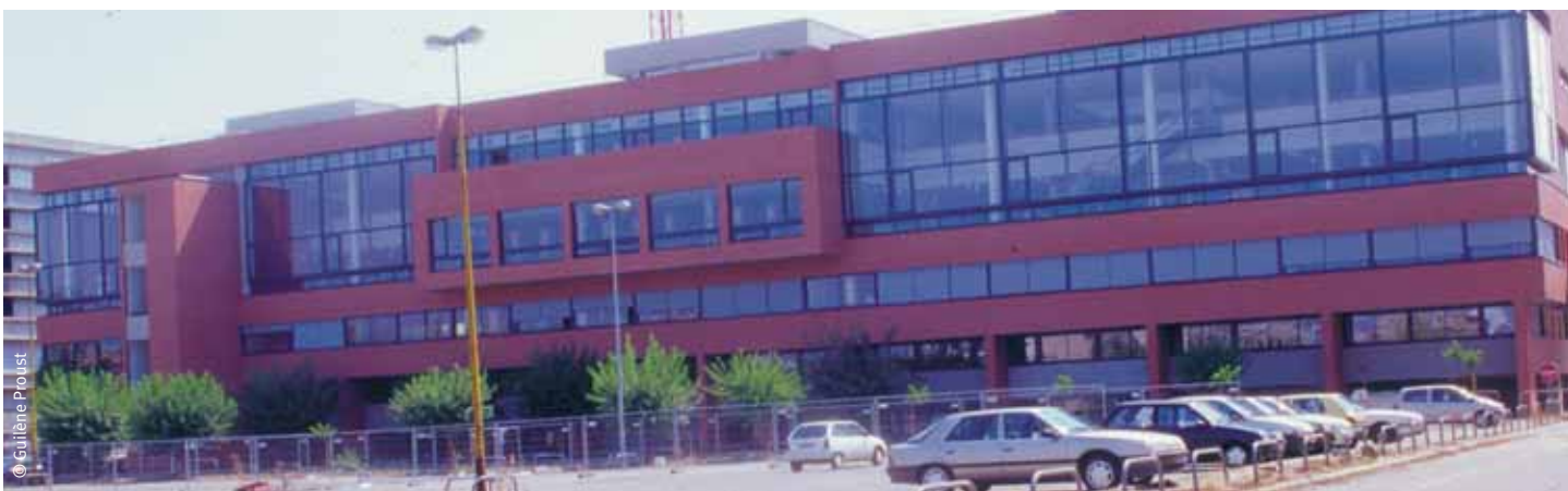
La Bibliothèque centrale universitaire conçue par Pierre Riboulet, façade Nord.
