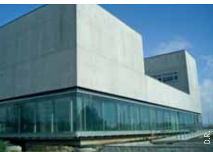
Médiathèque Floresca Guépin. En haut : la façade ouest. Ci-dessus : la façade sud-est et la rampe.
