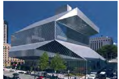
Vue extérieure de la Seattle Public Library de l'angle de la rue Madison et de la 4 e avenue.
