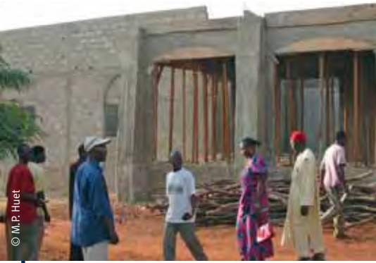
Visite du chantier de la bibliothèque de Faranah.
