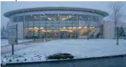
La construction de la bibliothèque d'Avoine (Indre-et-Loire), communauté de communes du Véron (architecte Pascale Seurin, 1 595 m 2 ), a bénéficié de crédits d'État.
